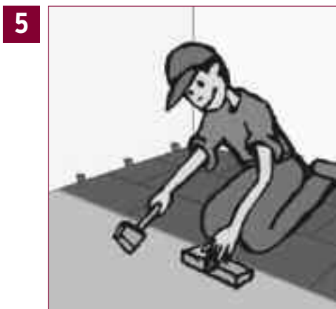
5 Una vez colocadas las lamas del lado más largo, golpear suavemente con el batidor de lamas.
